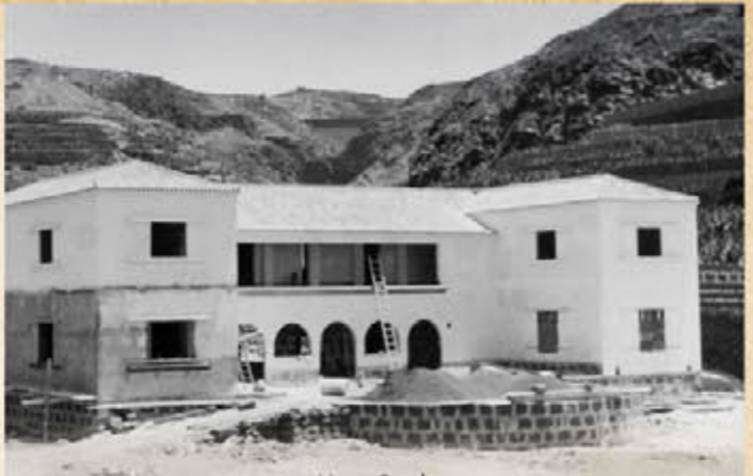
Hogar Rural en construcción en los años 50.
